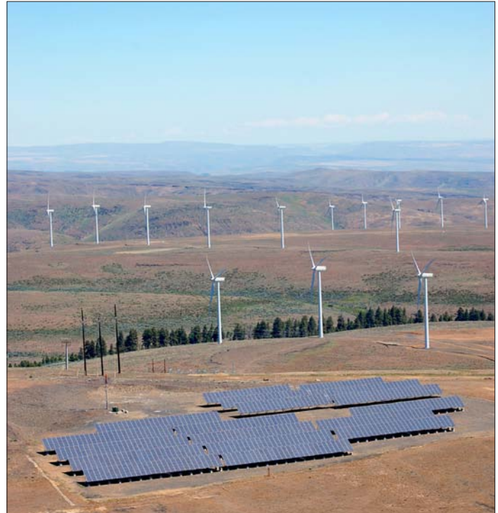
Wild Horse 的太阳能电池组电量达到 500 千瓦，是西北地区将日光转化为电能的最大的太阳能光伏发电科技样板项目。
