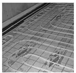
Radiant floor tubing ready for concrete pour
