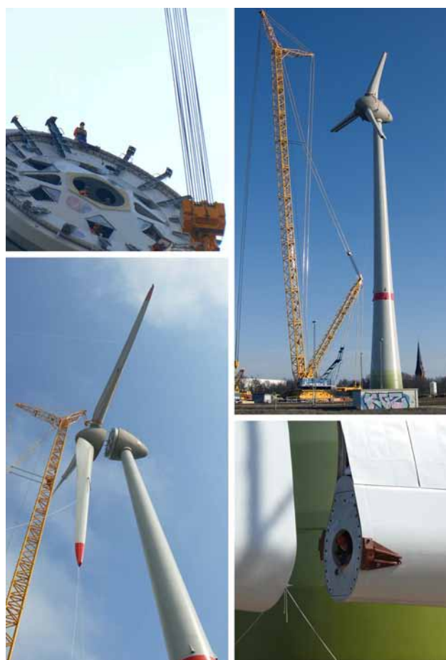
Enercon E126 under construction
